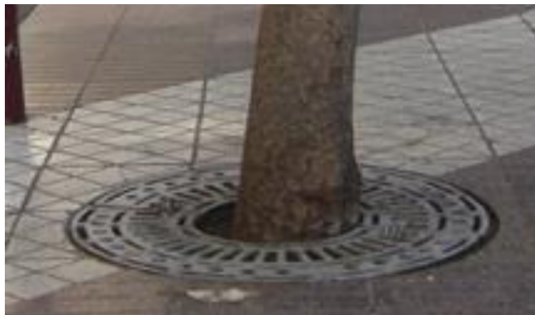
Figura 7: Grelha no centro de ferro fundido.
